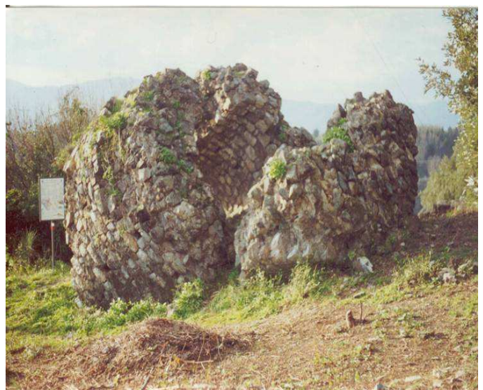
I resti della torre abbattuta
