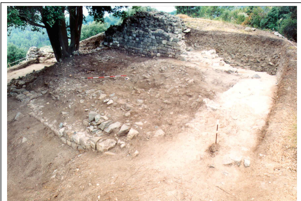
Depositi che indicano il cedimento strutturale (Baldassarri,2004,p.111)
