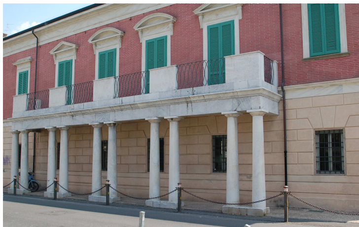
Figura 4: Palazzo Paolina (lato Piazza Shelley – lato ovest)
